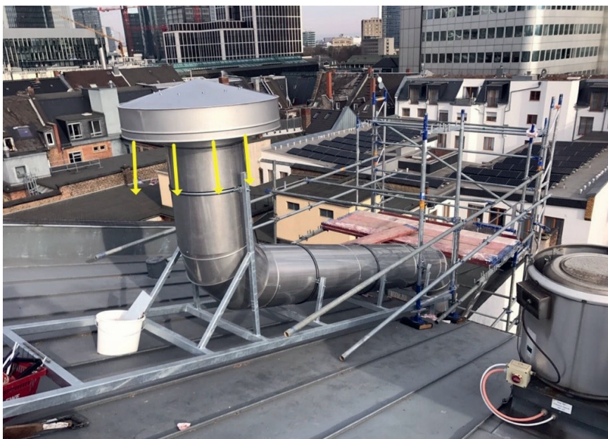
Abbildung III-1-10: links: Falsch gebaute Fortluftöffnung für Küchenabluft. Die Ausblasung erfolgt nach unten anstatt senkrecht nach oben
