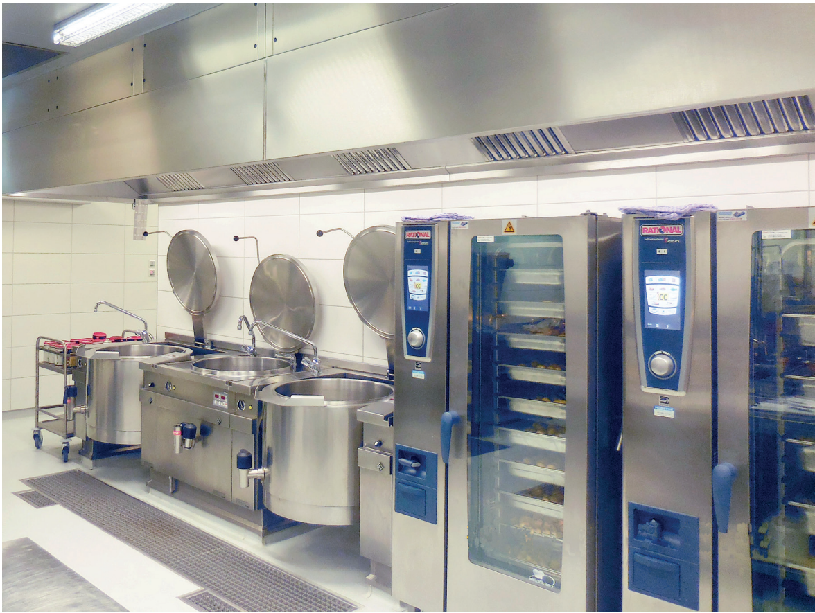
Abbildung I-9-1: Gerätegruppe zum Kochen und Dämpfen mit (Kipp-)Kochkesseln (lfd. Nr. 1.1 und 1.2) und Heißluftdämpfern (rechts im Bild), (lfd. Nr. 1.3)
