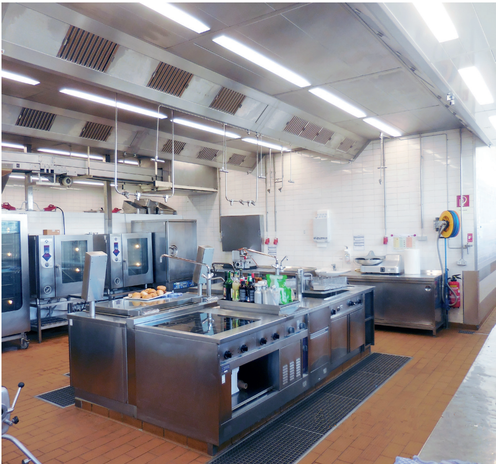
Abbildung I-5-6: Küchenlüftungsdecke mit einer ortsfesten Feuerlöschanlage
