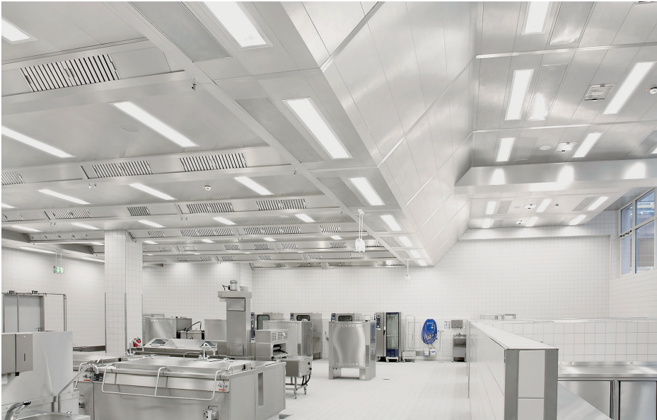
Abbildung II-3-3: Küchenlüftungsdecke mit trapezförmig angeordneten Aerosolabscheidern in Plenum-Bauart und mit Zuluftdurchlässen außerhalb der Kochbereiche, (Foto: Südluft Systemtechnik GmbH)
