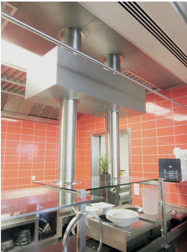
Abbildung II-2-7: 2 Stück Düsenplattenabsaugvorrichtungen in einem Frontcooking-Bereich, (Foto: Firma GIF ActiveVent GmbH)
