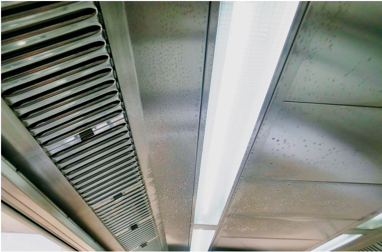
Abbildung II-3-6: Kondensation im Inneren einer Küchenlüftungsdecke trotz ausreichendem Abluftvolumenstrom als Folge falscher Anordnung der Aerosolabscheider
