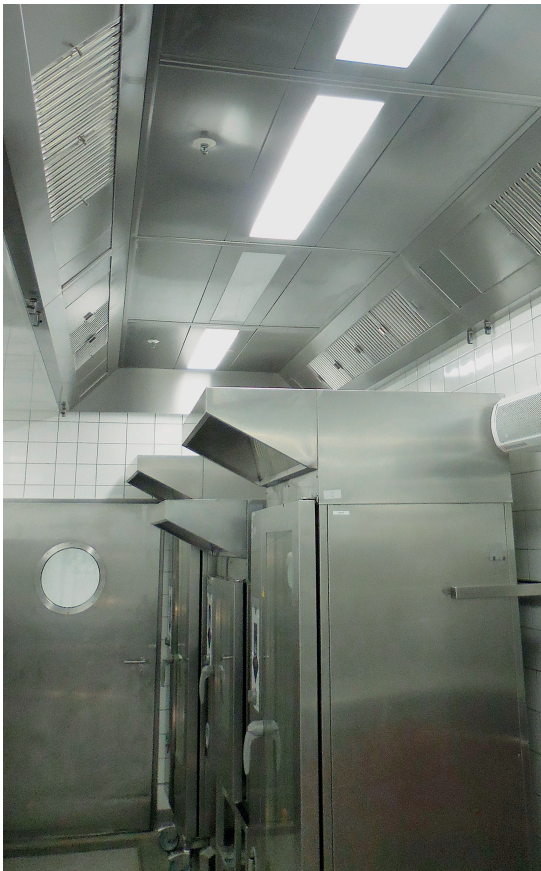
Abbildung II-2-6: Heißluftdämpfer mit Kondensationshauben und Küchenabluflhaube zur Abfuhr der thermischen und Stofflasten. Die Kondensationshauben sind mit dem Kaltwassernetz verbunden
