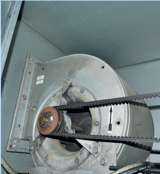
Abbildung III-1-2: Zuluftventilator Küche, mit der Außenluftansaugung aus Abbildung III-1-1. Die Verschmutzungen traten auf, obwohl der Ventilator hinter einem F9 Filter angeordnet war
