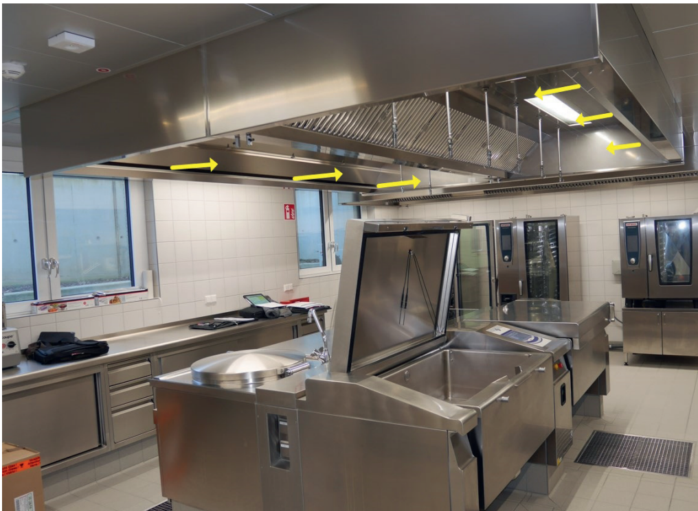
Abbildung II-4-2: Induktionshaube über einem Mittelkochblock, die gelben Pfeile zeigen die Einblasung der nicht beheizten Zuluft in der Haube
