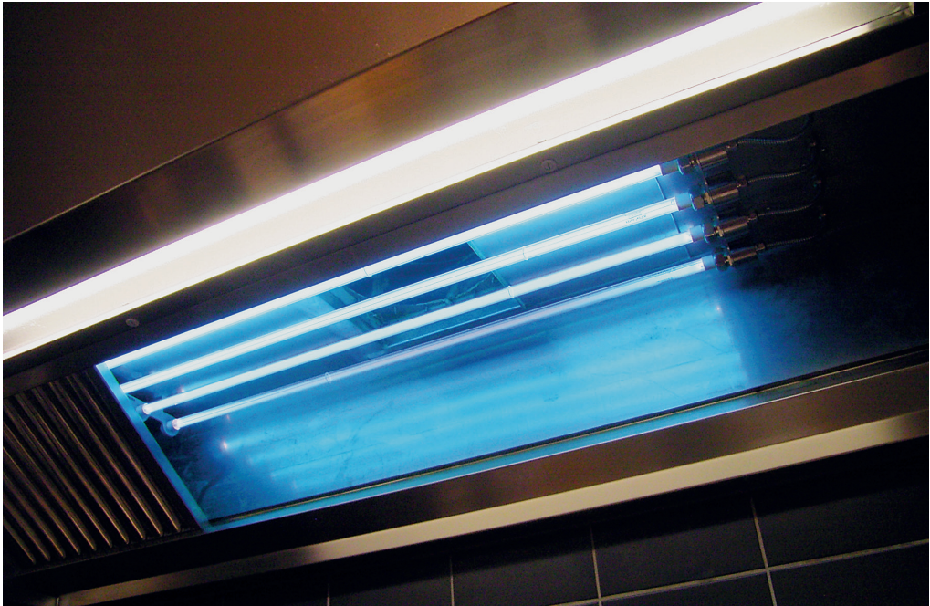
Abbildung II-9-4: UV-C-Anlage in einer Küchenlüftungshaube (Foto: IMPro GmbH)
