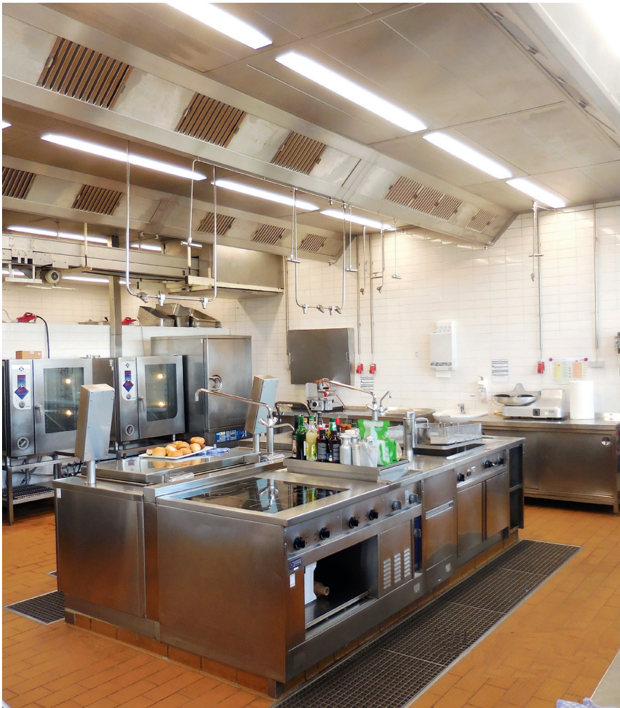
Abbildung II-10-1: Küchenlüftungsdecke mit einer stationären Feuerlöscheinrichtung in einer Großküche
