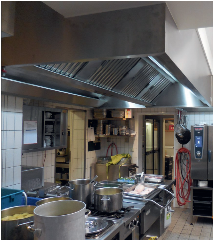
Abbildung II-4-1: Induktionshaube über einem Mittelkochblock
