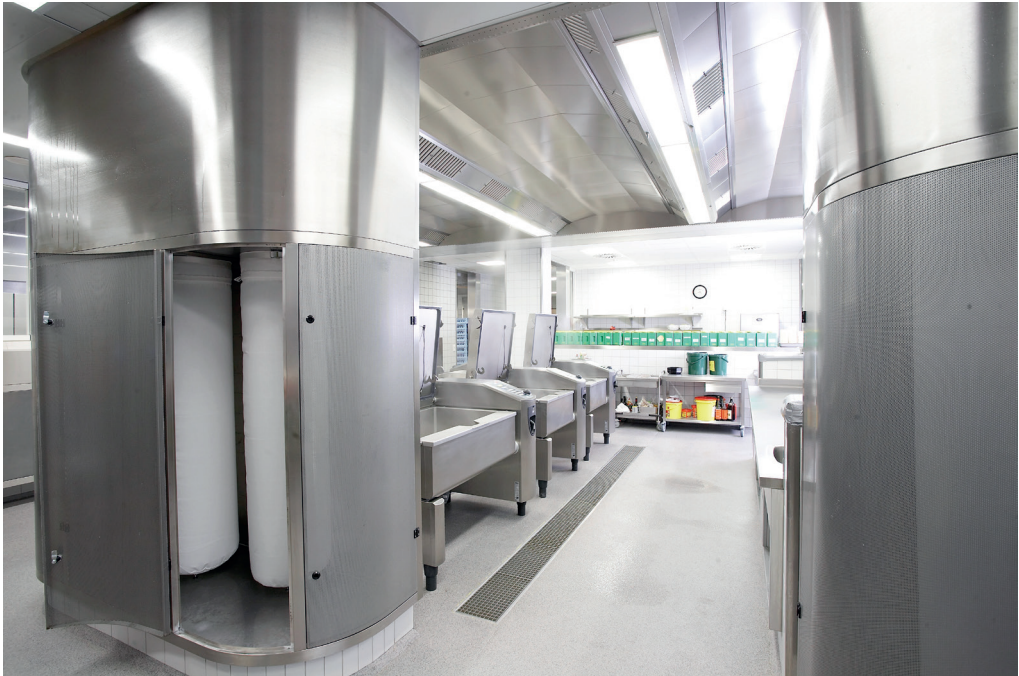
Abbildung I-4-4: Flächenförmige Quellluftauslässe im Aufenthaltsbereich (Quelle: Firma Halton Foodservice GmbH)
