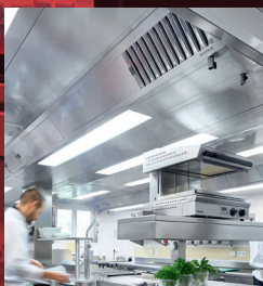
Lüftungsdecken
