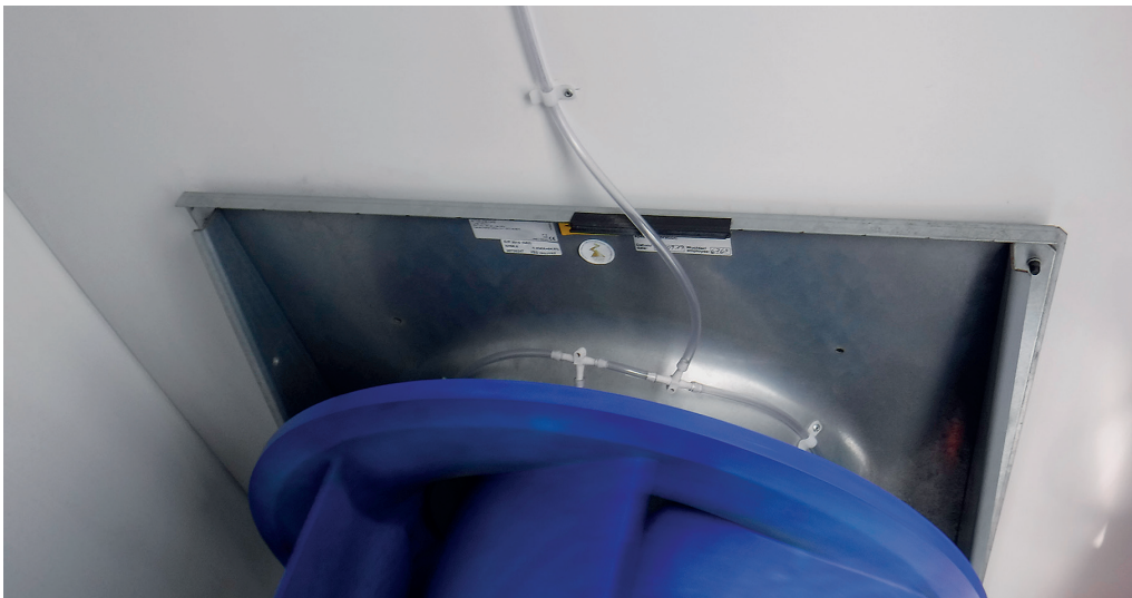
Abbildung II-7-1: Volumenstrommesseinrichtung an einem Ventilator mit freilaufendem Laufrad und rückwärtsgekrümmten Schaufeln
