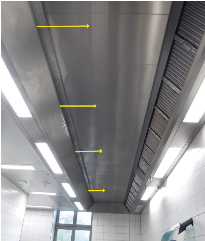
Abbildung II-4-3: Küchenlüftungsdecke mit erwärmter Induktionszuluft (gelbe Pfeile) und einer Reihe Aerosolabscheidern entlang der Wand
