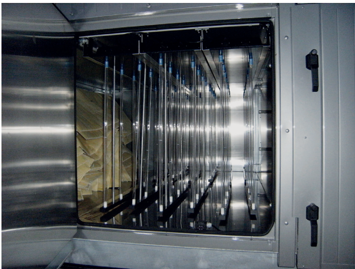
Abbildung II-9-7: UV-C-Strahler mit Vorfilter in einer Fotooxidationsanlage
