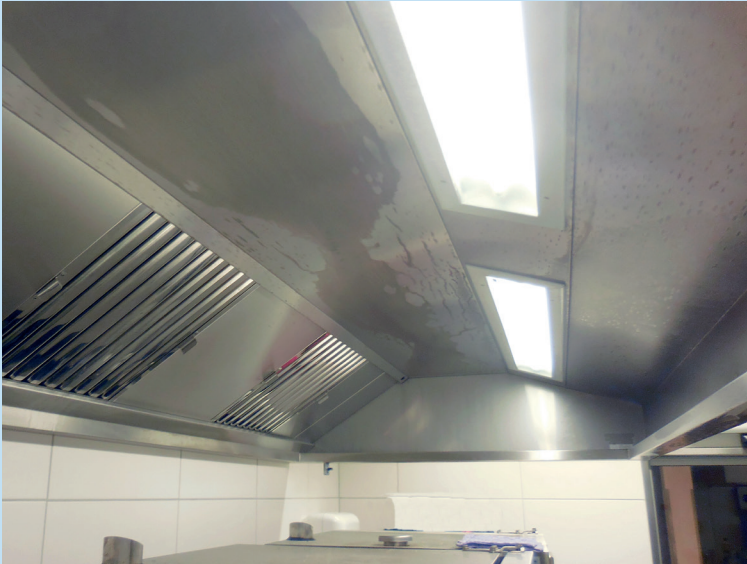
Abbildung I-9-8: Wandhaube mit nur rückwärtig angeordneten Aerosolabscheidern über Heißluftdämpfern
