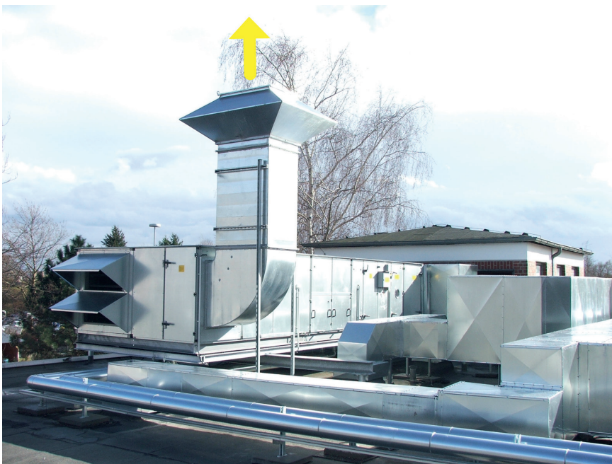
Abbildung III-1-9: Küchenlüftungsgerät mit fachgerechter Ausblasung der Fortluft mittels einer Deflektorhaube senkrecht über Dach
