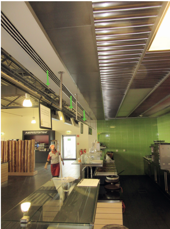
Abbildung I-6-2: Speiseausgabe mit Zuluftschleieranlage in einer Betriebskantine
