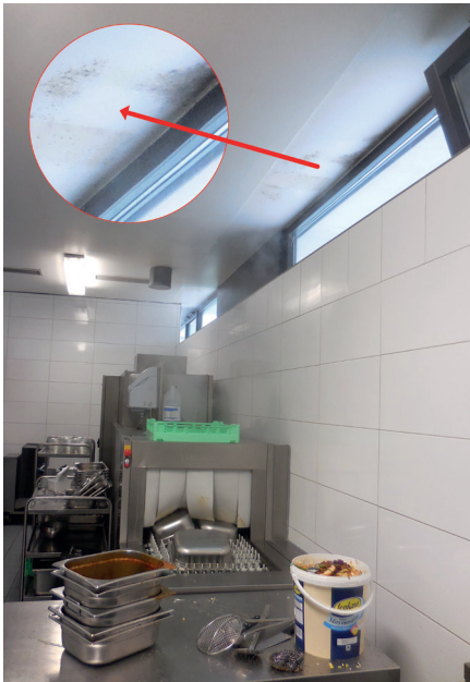
Abbildung I-7-1: Schimmelbildung durch unzureichende Lüftung einer Spülküche
