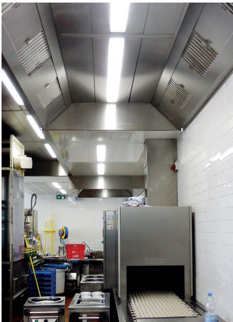
Abbildung I-7-5: Küchenlüftungsdecke in einer Spülküche
