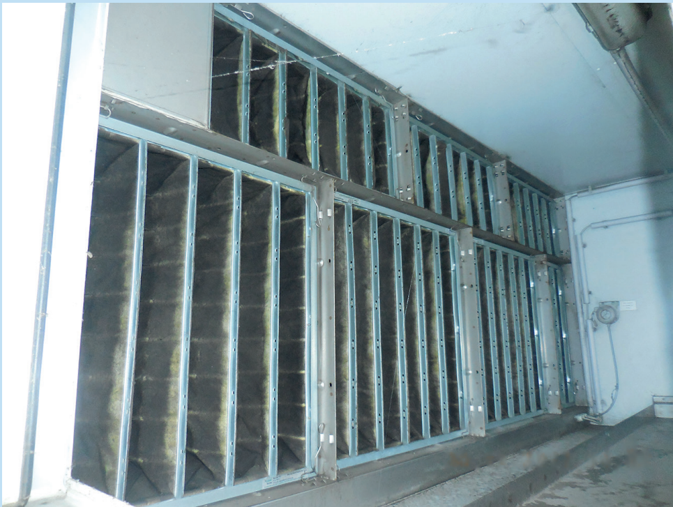
Abbildung III-1-4: Blick in die Außenluftfilterkammer
