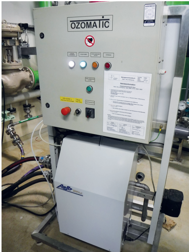
Abbildung II-9-1: Ozongeneratoren zur Erzeugung von 10 g Ozon/h aus Luftsauerstoff (oben), Kompressor-, Trockeneinheit (unten)
