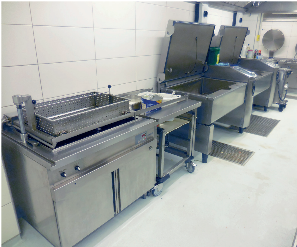
Abbildung I-9-2: Gerätegruppe zum Frittieren und Braten mit Großfritteuse (links), (lfd. Nr. 2.8) und zwei multifunktionalen Cooking-Centern
