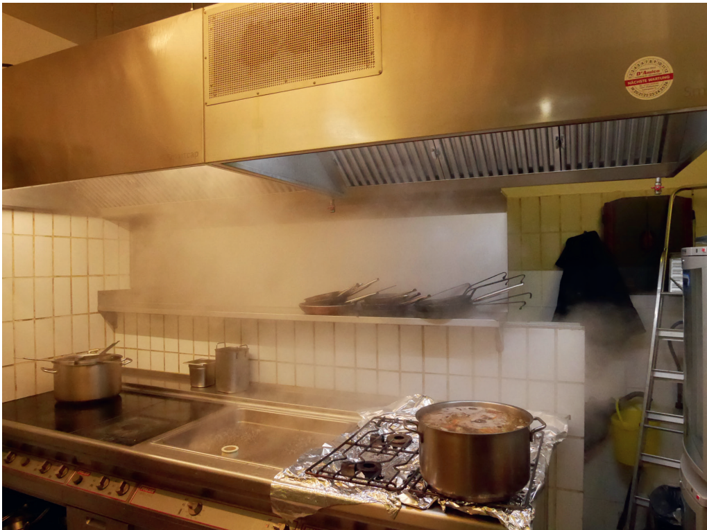
Abbildung II-2-8: Haube einer Küchenlüftungsanlage für Abluft und Umluft die nach weniger als einem Jahr auf Grund mangelnder Gebrauchstauglichkeit demontiert wurde. Stattdessen wurde eine reine Zu- und Abluftanlage eingebaut
