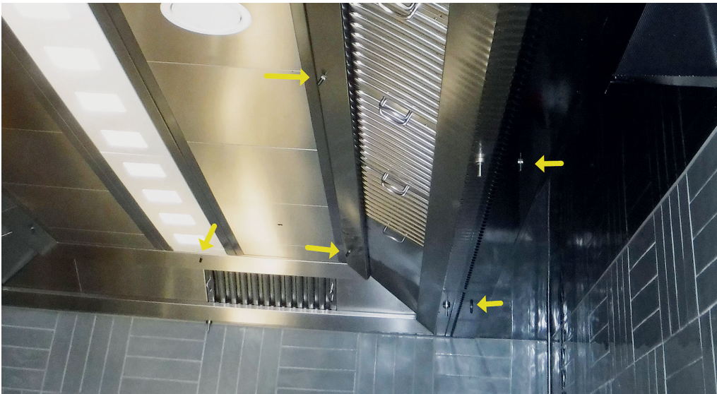
Abbildung II-7-7: Differenzdruckmessnippel in der Zuluft und der Abluft einer Küchenlüftungsdecke
