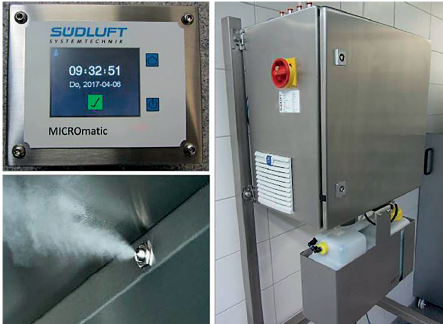
Abbildung II-9-11: mikrobiologische Aerosolnachbehandlung zum Versprühen von Enzymen in den Abluftsammelkanälen von Küchenlüftungsdecken (Foto: Südluft Systemtechnik GmbH)
