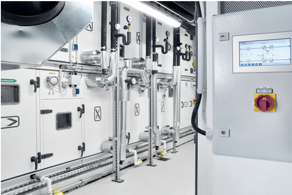
Abbildung III-1-8: Lüftungszentralgerät mit Wärmerückgewinnung als Kreislaufverbundsystem (KVS), (Foto: TROX GmbH)
