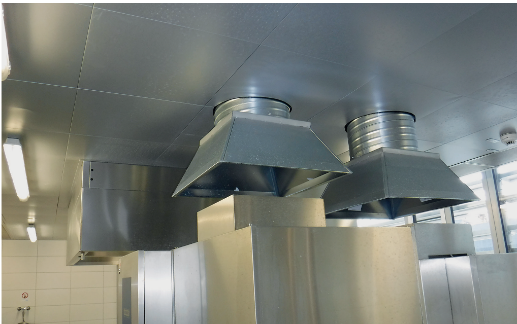
Abbildung II-6-2: im Bild vorne: Abzugshauben oberhalb der in den Spülmaschinen eingebauten Ventilatoren. Im Bild hinten: Abzugshaube oberhalb des Spülmaschinenauslaufs
