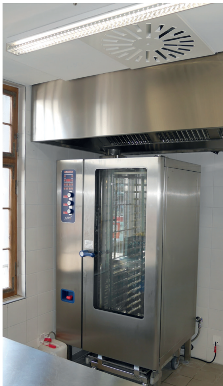
Abbildung I-4-2: Ungünstig platzierter Dralldurchlass, der die Absaugung der Wrasen stört
