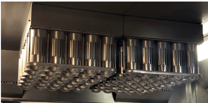
Abbildung II-5-4: Aerosolabscheider in Sonderbauform
