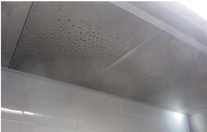
Abbildung I-5-5: Kondensation in einem nicht ausreichend abgesaugten Bereich einer Küchenlüf- tungsdecke oberhalb von Heißluftdämpfern
