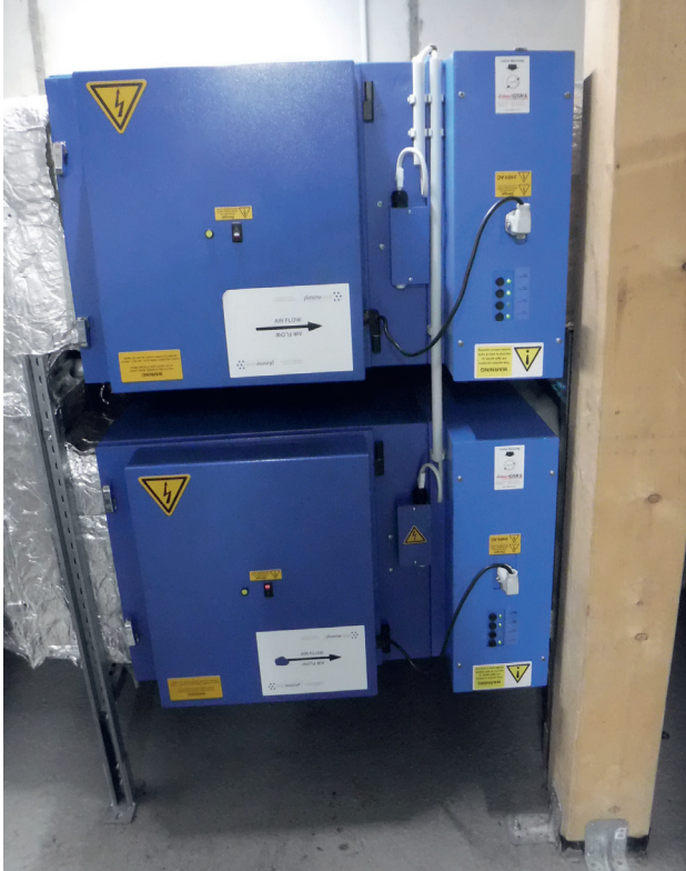
Abbildung II-9-10: Küchenabluftreinigungsanlage bestehend aus zwei Modulen für jeweils 7500 m 3 /h, bestehend aus Metallgestrick- filter, elektrostatischen Filter und UV-C Strahlern
