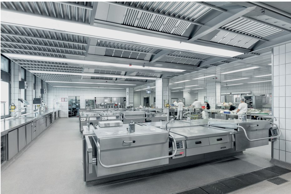
Abbildung II-3-4: Küchenlüftungsdecke in Flachbauweise mit Schwerpunktabscheidern über Kochgeräten mit hohen Lasten und Zuluftdurchlässen außerhalb der Kochbereiche, (Foto: GIF ActiveVent GmbH)
