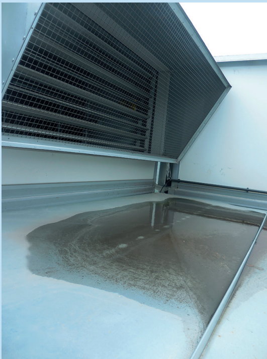
Abbildung III-1-3: Außenluftansaugung eines Zuluftgerätes für eine Küche
