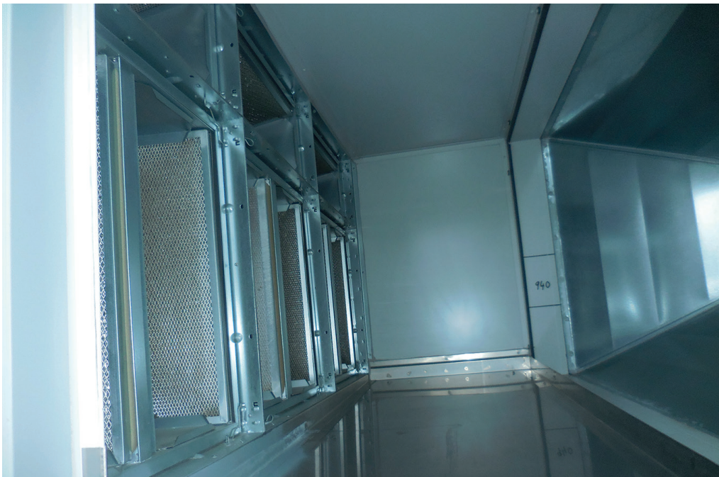
Abbildung III-1-5: erste Filterstufe in einer Küchenabluftanlage, als Metallgestrickfilter ausgeführt
