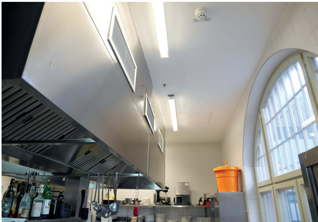
Abbildung I-4-1: Oberhalb einer Haube ungünstig angeordnete Zuluftdurchlässe, die zu Zugerscheinungen führen
