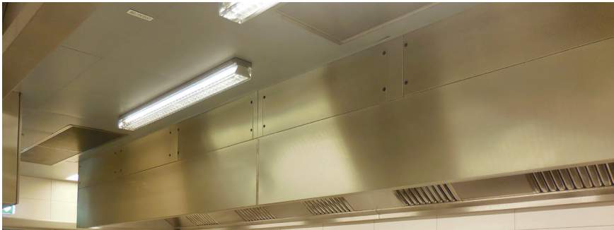
Abbildung I-4-3: Laminar-Zuluftauslässe in einer Küche
