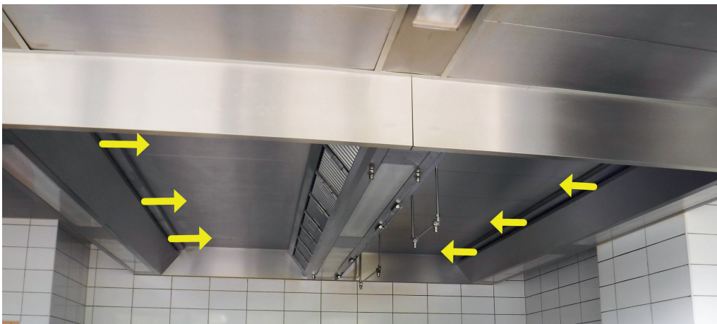
Abbildung II-4-4: Küchenlüftungsdecke mit Induktionszuluft (gelbe Pfeile) über einem Mittelkochblock
